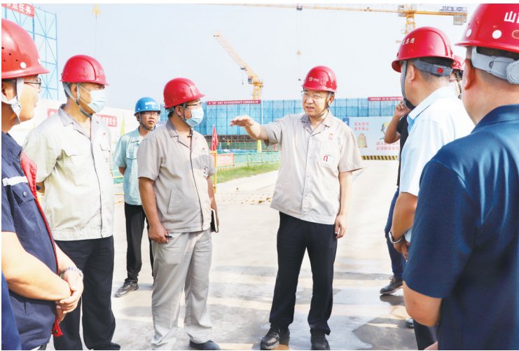
配套住宅项目建设现场
